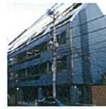
既存ビルでの継続的省エネ改修とテナントとの情報共有
