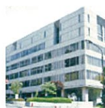
耐震改修にあわせた省エネ改修
