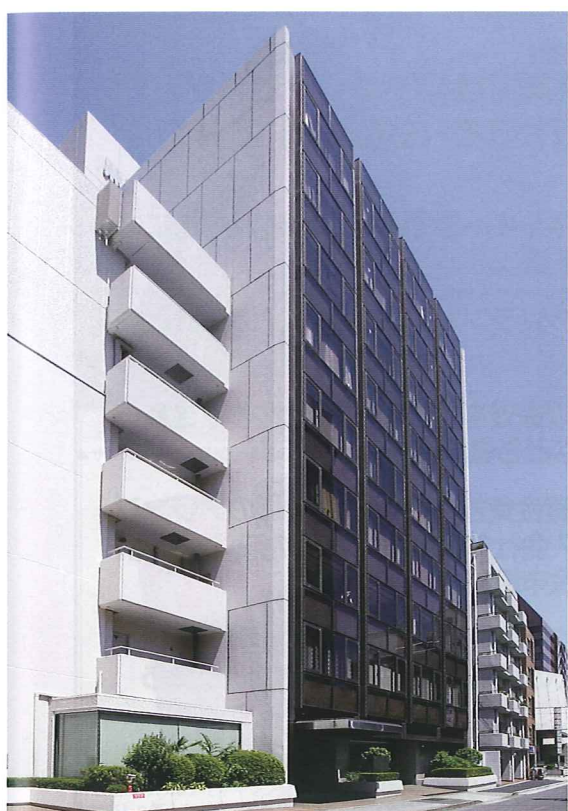
▲オーナーやテナント、管理会社が一体となって省エネに取り組んでいる黒龍堂芝公園ビル
