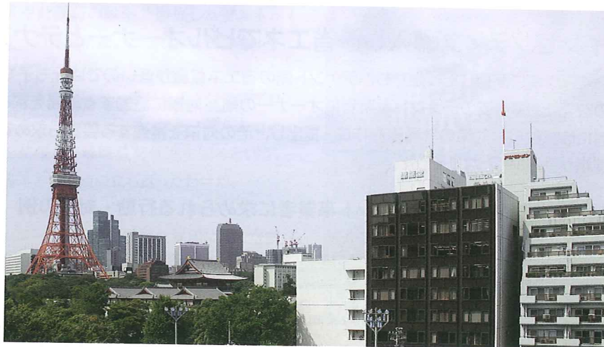
東京タワーや増上寺のすぐそばにある黒龍芝公園ビル。テナントや設備管理会社の運用改善などにより、CO 2 排出量を22%削減達成した
