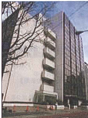
東京タワーや増上寺にも近い黒龍堂芝公園ビル。省エネのみならず、機能性や美観の向上で資産価値を上げることに成功した
